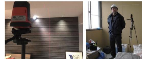
図9 水平器による墨出しとフック3点による取付
